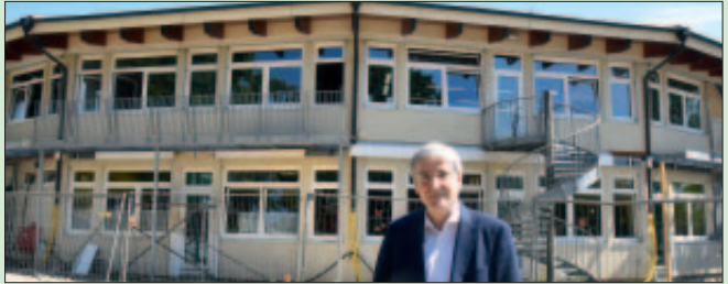
■ Die Diesterweg-Schule mit ihrer markanten Architektur bekommt aus Brandschutzgründen einen „Gürtel“ aus Metall.
