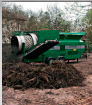
■ Die mobile Siebtrommel bearbeitet den Boden direkt auf dem Grundstück.
