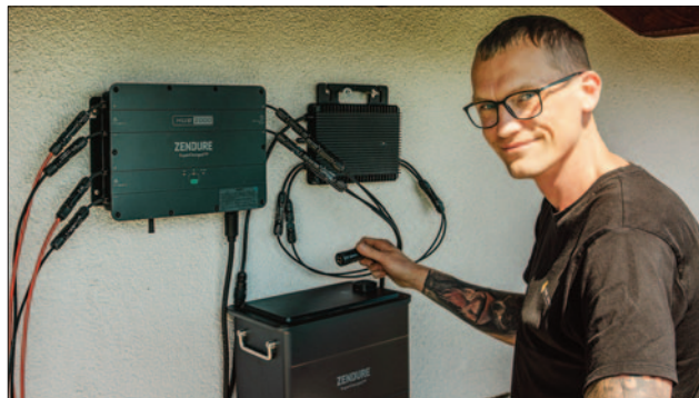
■ Elektromeister Daniel Zarske installiert Elektrolösungen, unter anderem für Smarthome und erneuerbare Energien.
